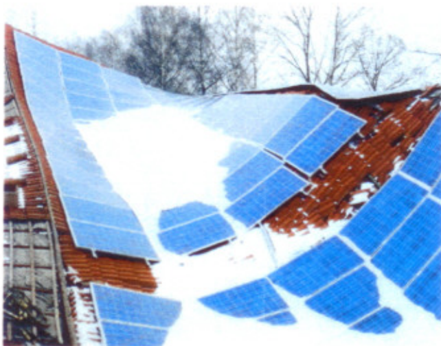
Versicherungen müssen auch Schäden durch konstruktionsbedingte Mängel zahlen, wie z.B. Schäden durch Schneebruch.
