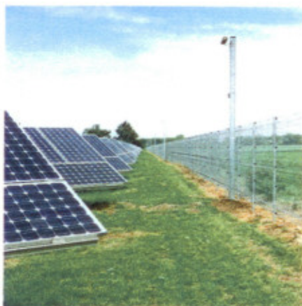
Im Visier: Bei großen Freiflächenanlagen werden verstärkt feste Zäune und Videoüberwachung eingesetzt.
