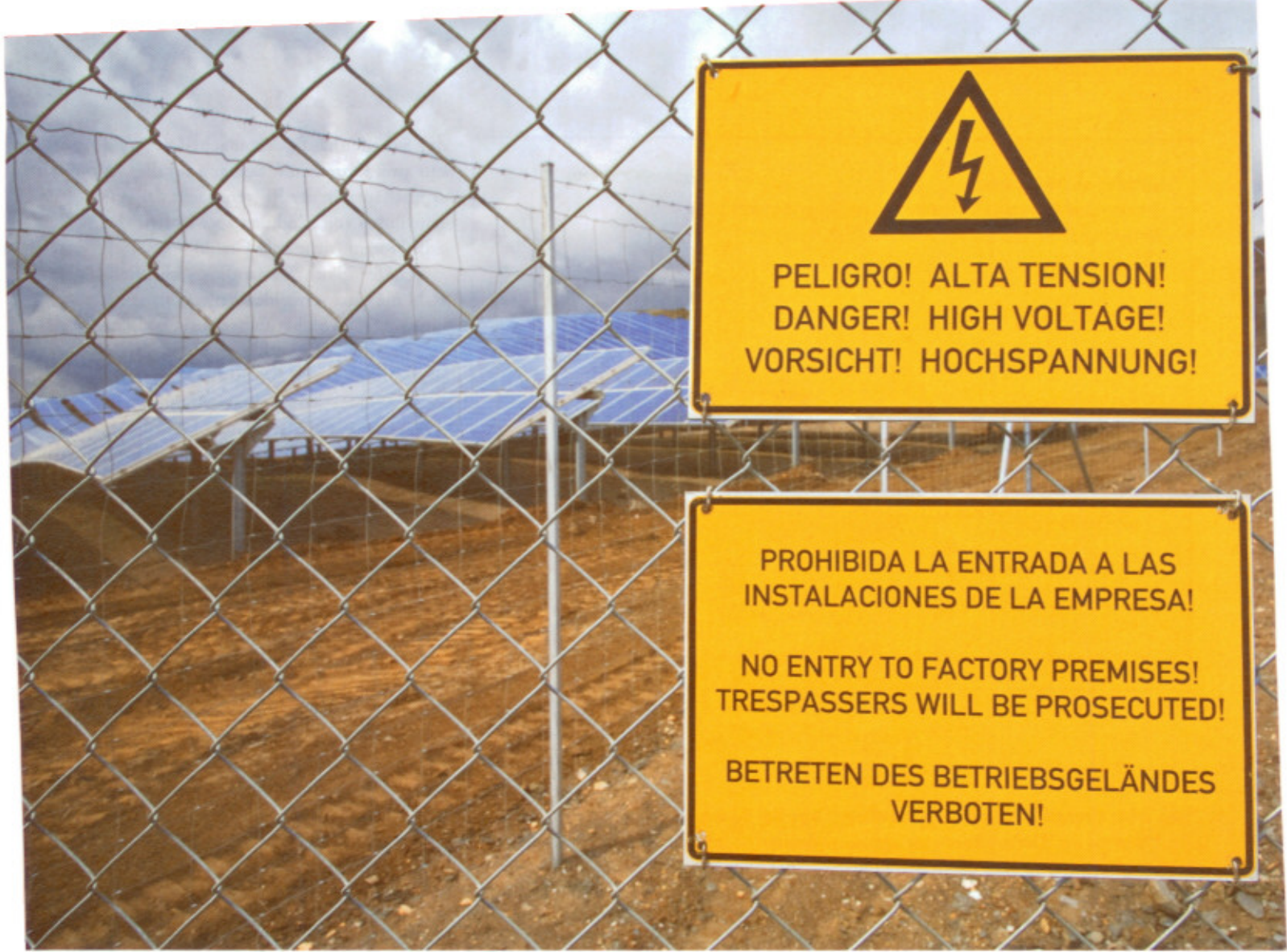
Warnung: Diese Großanlage mit 23 Megawatt am Rand der spanischen Sierra Nevada ist gut abgesichert. 140.000 Module sind hier verbaut.
