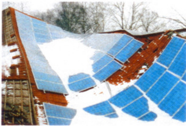
So kann eine zu hohe Schneelast zur Zerstörung von Dach und Photovoltaik-Anlage führen.
