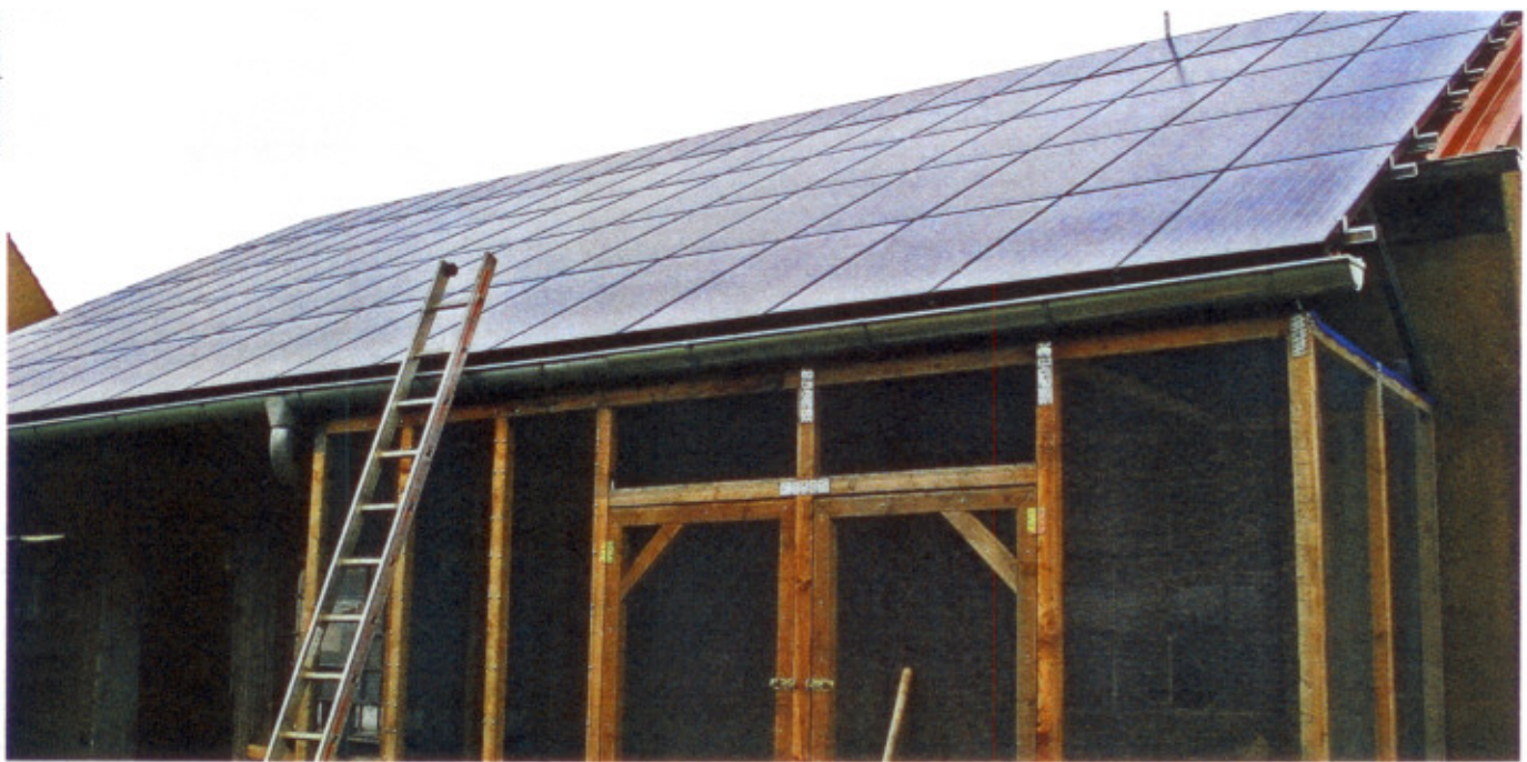
Dieser Vorbau könnte bei heftigem Schneefall sehr leicht in die Knie gehen.
